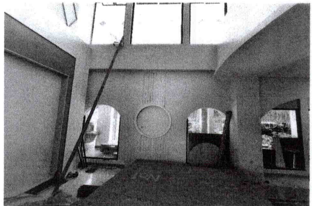
Supply & install Pemasangan gipsum lantai loby
