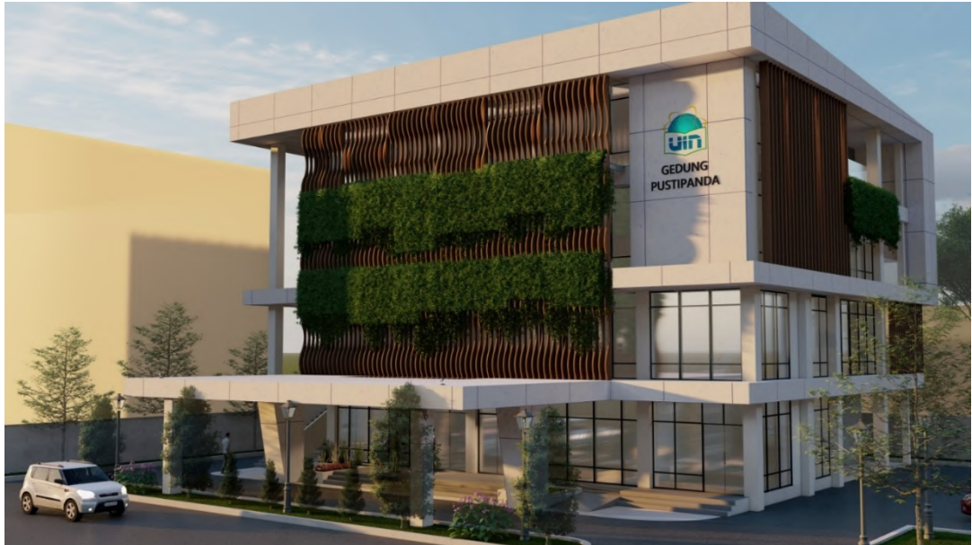
Gambar 1.3 Pembangunan Gedung PUSTIPANDA
